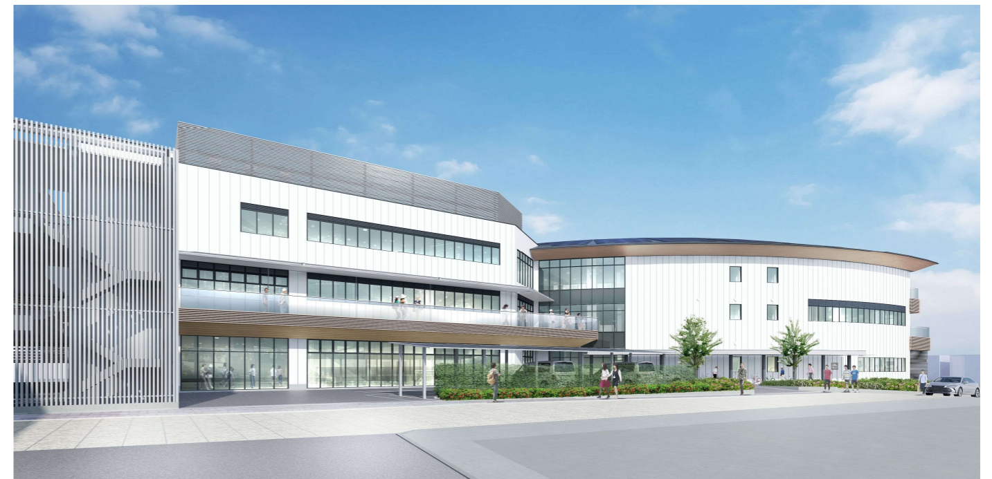
④ 南西側外観
