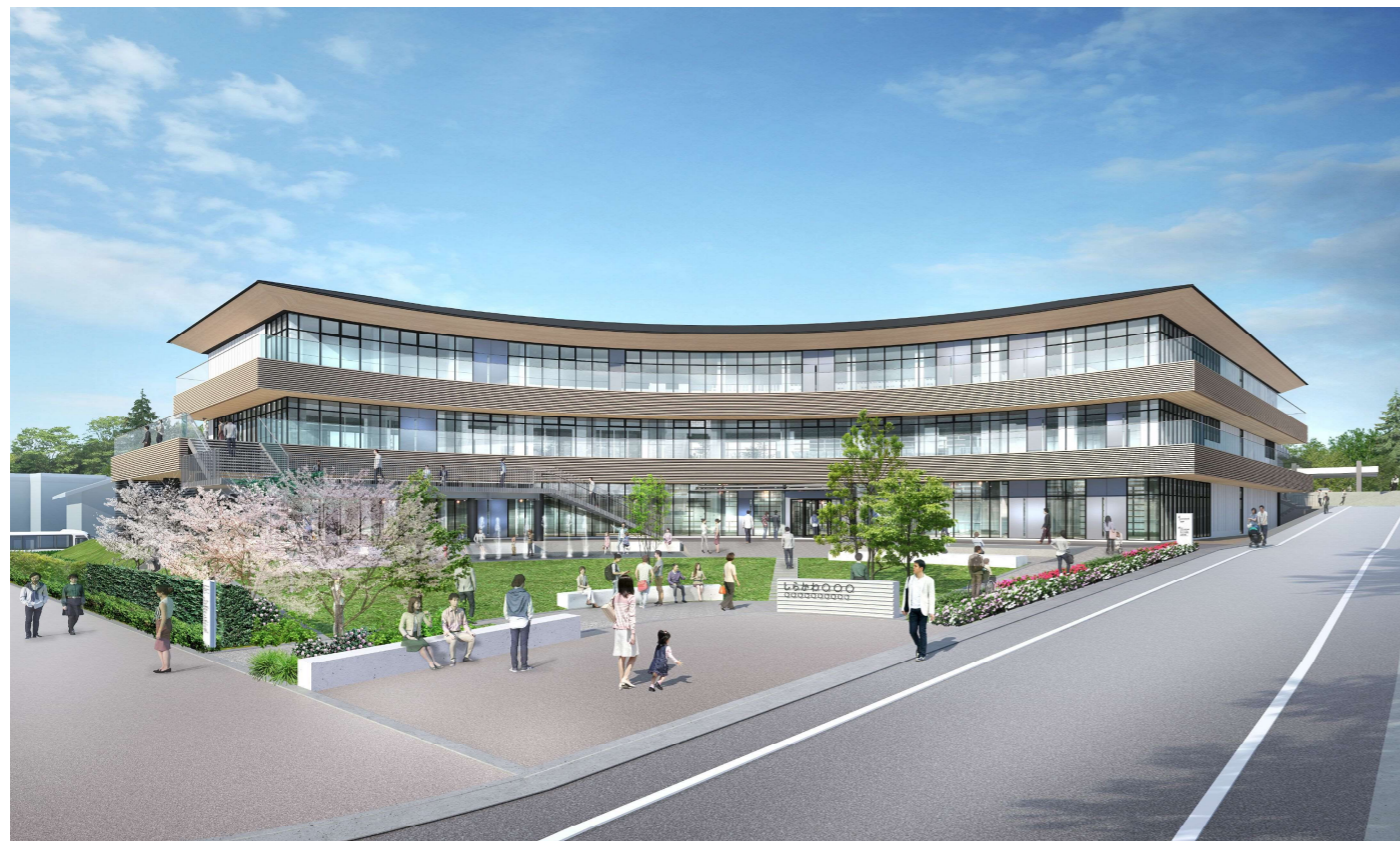
③ 北東側外観
