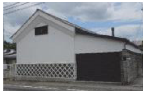
旧明治政府指定米倉庫
