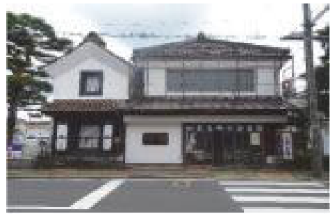
奈良屋呉服店建造物群
