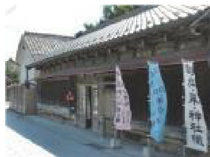
本家富川屋染物店建造物群
