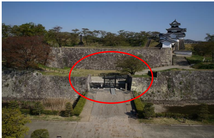
▲清水門跡現況(写真中央、南から)
