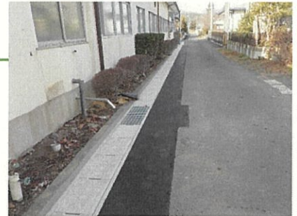
側溝改修状況
