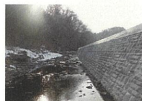
改修した護岸
