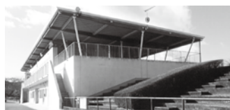
陸上競技場管理棟
