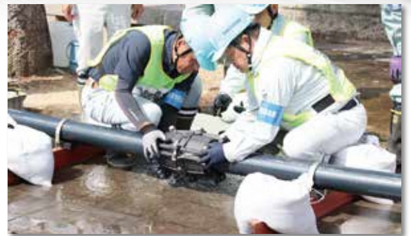
白河地区管工事協同組合による水道応急復旧訓練
