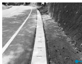
改修された側溝
