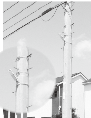
新たに設置したLED街灯
