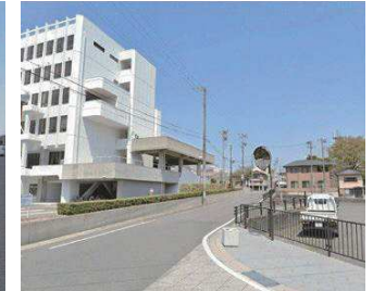
③ 廃道予定箇所南側から
