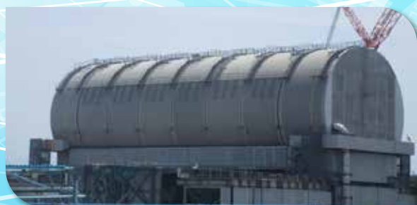
2021年2月に燃料取り出しが完了した3号機
