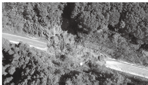
令和元年東日本台風
