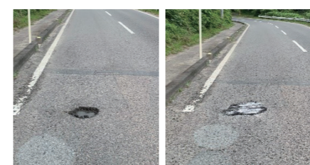
▲改修前 ▲改修後
