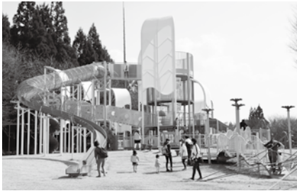
令和3年2月の地震で破損し修復工事が完了し家族連れでにぎわう鶴子山公園(表郷金山)
