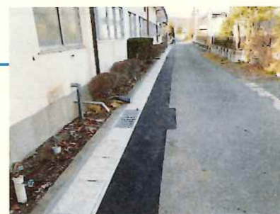
側溝改修状況
