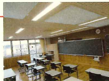
照明LED化済み教室 (白河第二中学校)
