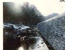
改修した護岸
