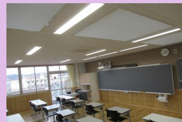
〔照明LED化済み教室 (白河第二中学校) 〕
