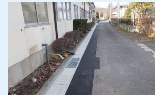
〔側溝改修状況〕
