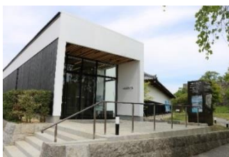
【増築部分外観】
