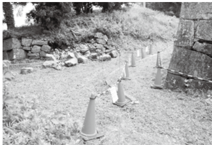
搦手門脇東側石垣状況
