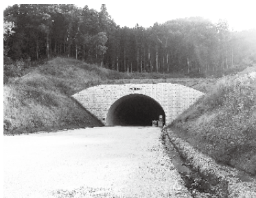
南湖トンネル（栄町側より）
