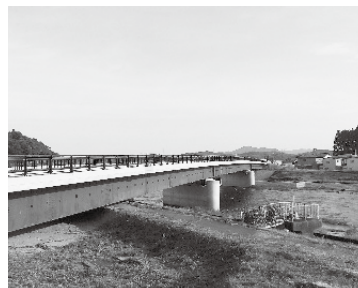
小峰大橋（葉ノ木平側より）
