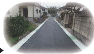
側溝改修状況▶
