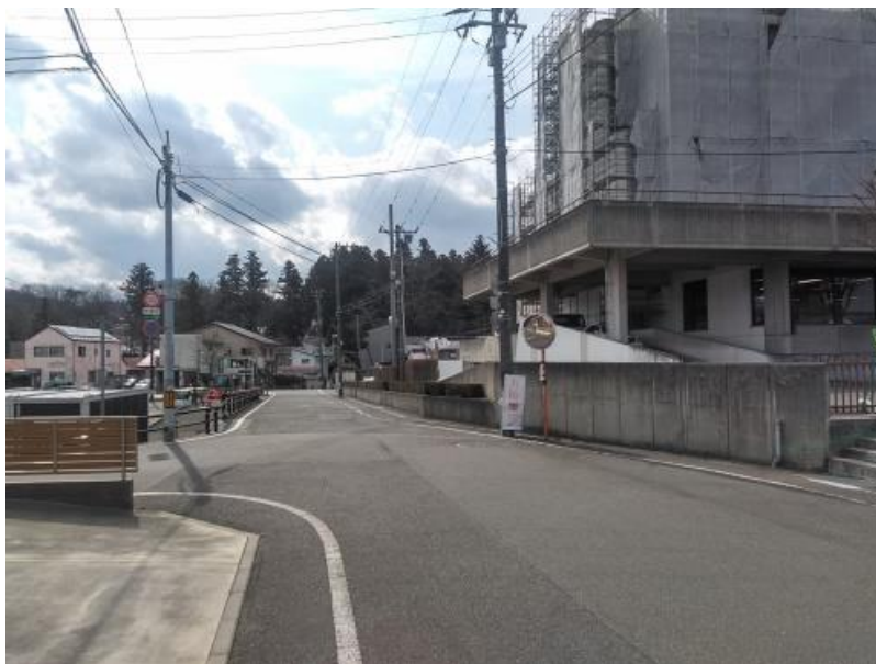
写真 現況写真
