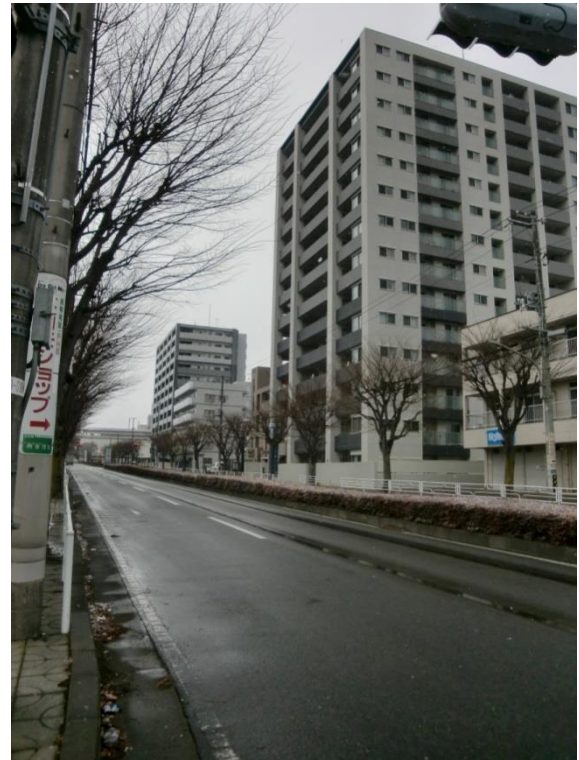
② 新白河駅周辺の高層ビル
