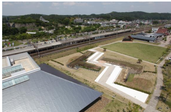
④小峰城道場門遺構、駅前イベント広場
