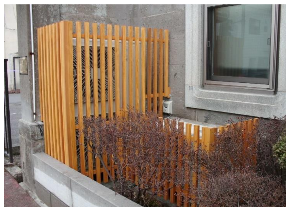
外構：室外機の遮へい、植栽
