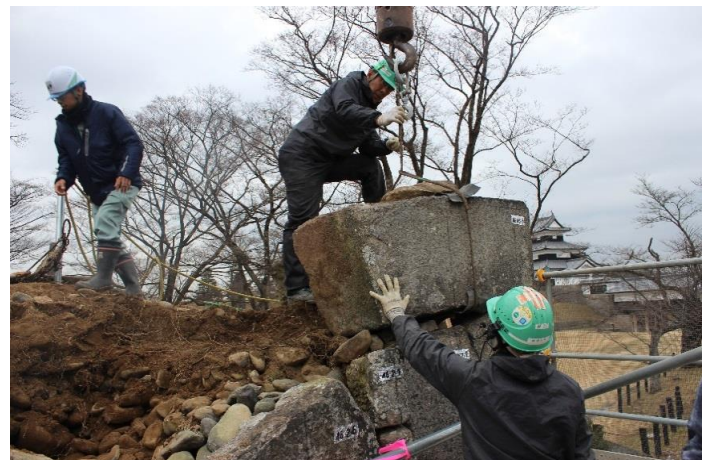
帯曲輪門北側石垣解体状況
