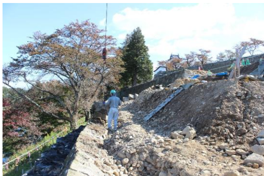
水懸口北面石垣解体状況
