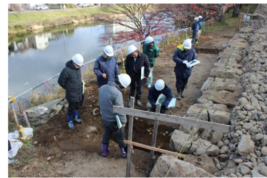
第33回石垣検討委員会(令和元年11月30日)
