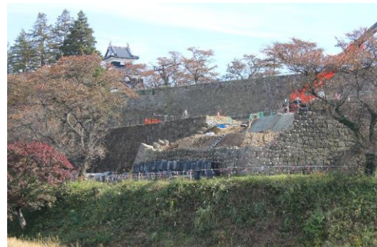
水懸口北面石垣解体状況(遠景)
