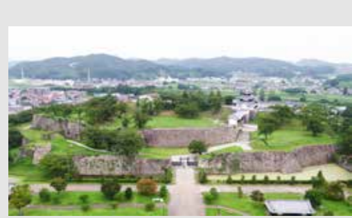
災害復旧が完了した小峰城
