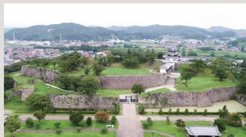
災害復旧が完了した小峰城
