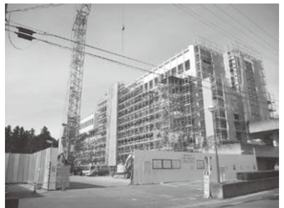
〈本庁舎耐震補強〉
