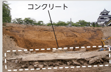
石垣裏側のコンクリート
