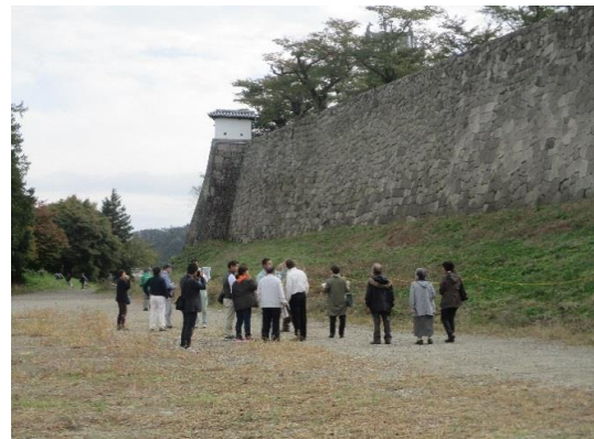
小峰城石垣修復状況一般公開 (平成30年10月14日)
