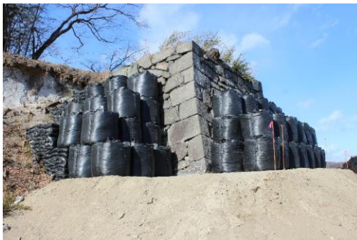
鎮護神山東面石垣養生状況
