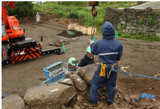
築出櫓周辺石垣解体状況
