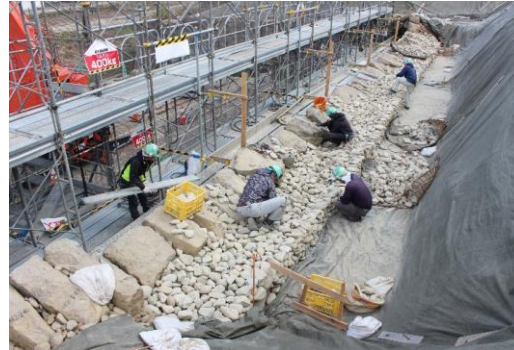
築出櫓周辺石垣復旧状況
