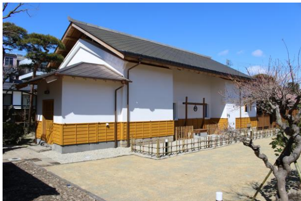
旧脇本陣柳屋旅館蔵座敷・外観
