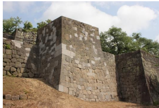
月見櫓跡 石垣復旧状況
