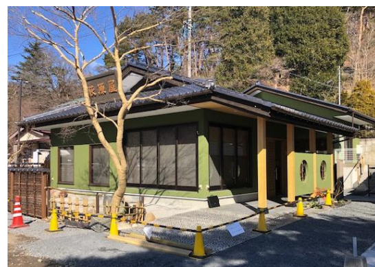
改築後(H31.1.29日竣工)
