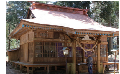
▲白河関跡に鎮座する白河神社。老朽化していた拝殿の屋根が、銅板ぶきに修繕されました。
