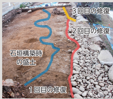
▲帯曲輪北面石垣の修復痕跡
