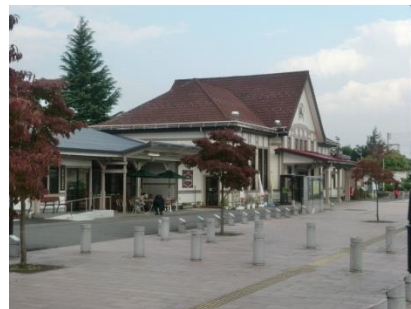
大正建築の白河駅舎(旧三の丸所在)
