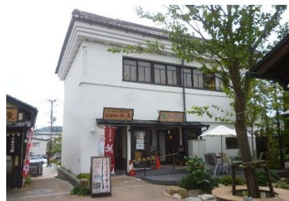
旧商工会議所建造物(中町)
