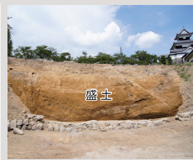
▲本丸南面石垣の裏側 (南から)
