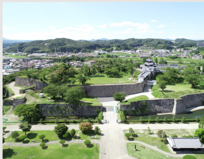
▲石垣の復旧が完了した小峰城
