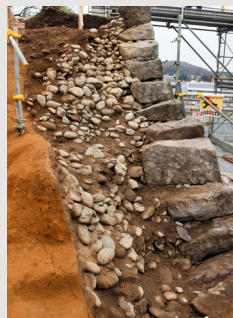
▲小峰城の石垣断面と伝統的な石垣の積み方
