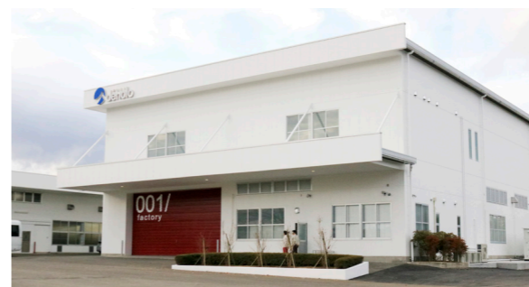
▲完成した同社福島工場
