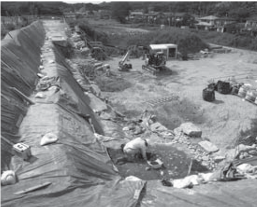
〈築出櫓周辺部石垣解体調査状況〉
