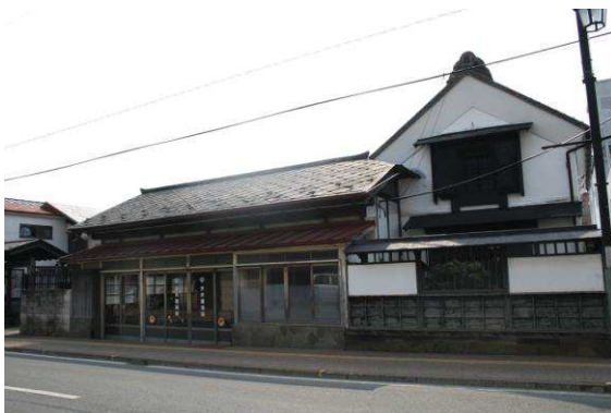
③ 今井醤油店建造物群（天神町）
