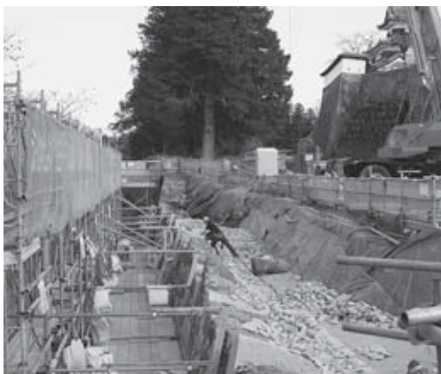
〈小峰城跡石垣復旧工事〉
