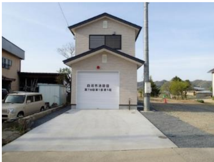
【白河地区 田島消防屯所】
