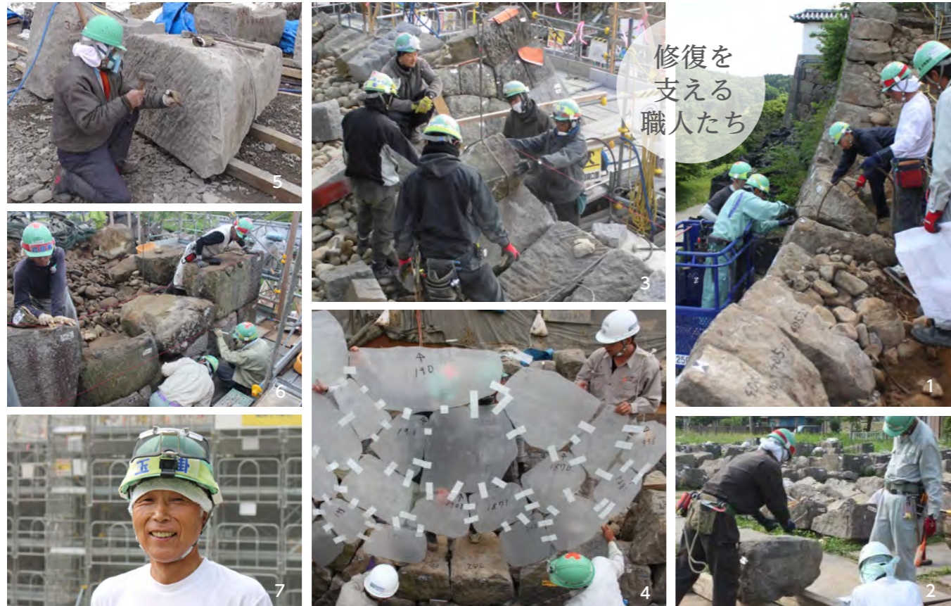
1. 本丸北面の解体作業 2. 追廻地区での石材調査 3. クレーンを使った積み上げ作業 4. プラスチックの型紙を使った石積みシミュレーション 5. 石材加工の様子 6. 石の積み上げ作業 7. 地元石工職人の土門さん
