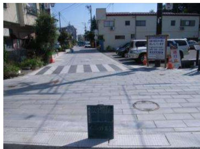
整備後(石畳による舗装)
