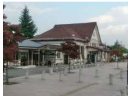
大正建築の白河駅舎(旧三の丸所在)
