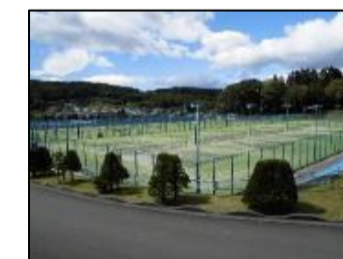
H27.10.1(施設改修後の全景)
