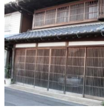
○木製またはアルミ製格子等による目隠しをした車庫
