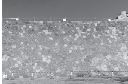
積み直しが完了した本丸南面の石垣
