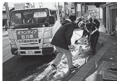
▲除雪作業の様子
