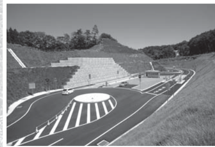
▲白河中央スマートインターチェンジ
