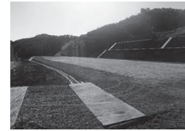
▲白河仮置き場第1工区(南側)
