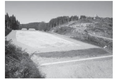
▲白河仮置き場第1工区(北側)
