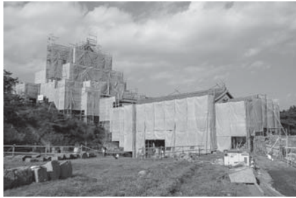
修復中の三重櫓・前御門
