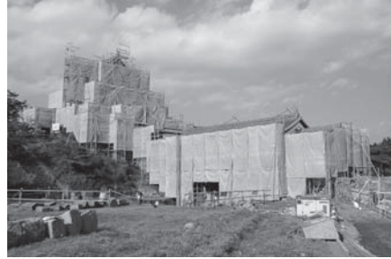
修復中の三重櫓・前御門
