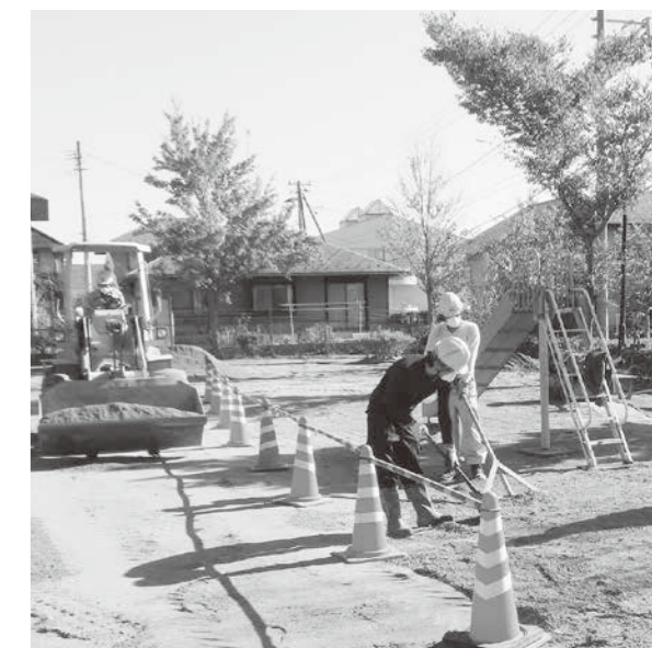
▲公園の表土除去作業の様子。表土を除去した後、山砂を入れ表面を整えます。
