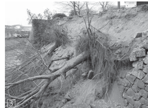
①最も被害が大きかった本丸南面石垣 ②石垣の背面に用いたコンクリートが倒れた姿（本丸南面） ③樹木とともに石垣が崩れた竹之丸南面
