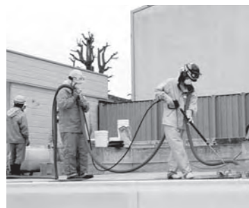
▲洗浄機でのプールサイドの除染
